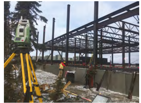
Un arpenteur vérifie les lignes de quadrillage d'un nouveau bâtiment. Chaque site présente ses propres dangers et risques.
