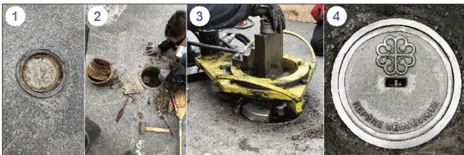
Figure 9 : Processus de fabrication mécanique du regard protecteur d'un repère géodésique
