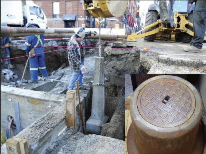
Figure 2 : Installation d'un repère géodésique (monument piédestal de 5 pieds) avec un regard protecteur et un couvercle de protection
