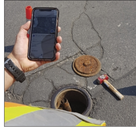
Figure 7a: Exemple d'inspection avec Collector for ArcGIS
