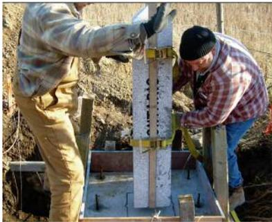
Marquage précis sur la base de béton et mise en place du monument de granite
