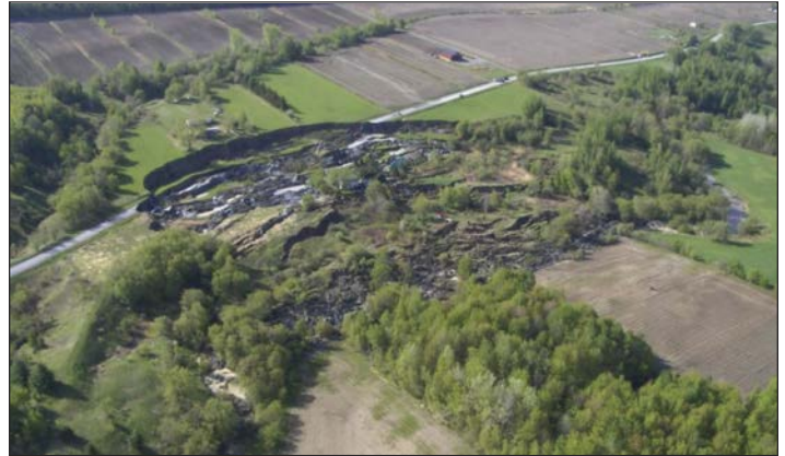
Figure 4 : Exemple d'un glissement de terrain fortement rétrogressif (étalement) (source : MTMDDET)
