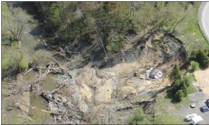
Figure 3 : Exemple d'un glissement de terrain rotationnel (source : MTMDDET)
