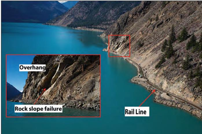
Figure 1 - Voie ferrée du CN à Seton Lake, en Colombie-Britannique. Le 9 février 2015, un éboulement s'est produit, laissant à nu un dièdre rocheux instable.
