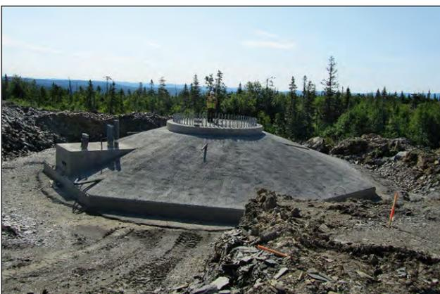
**Levé d'une fondation d'éolienne à la suite du décoffrage et avant le remblai pour validation de conformité de l'implantation en position et en élévation**
