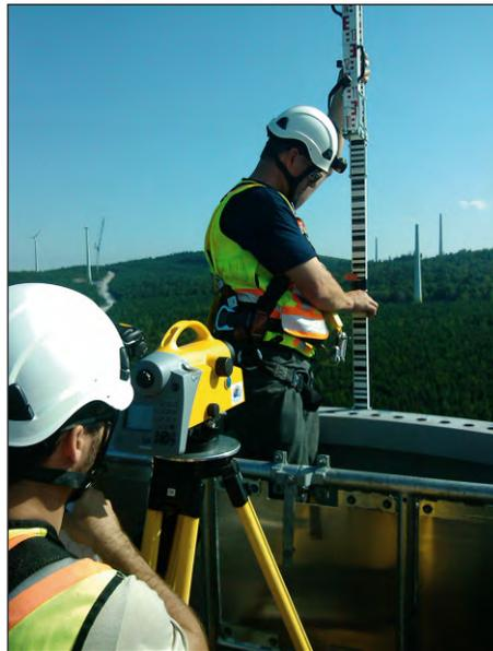
**Nivellement de précision du sommet d'une tour de 100 m pour permettre la fabrication de composantes de correction avant l'installation de la nacelle**
